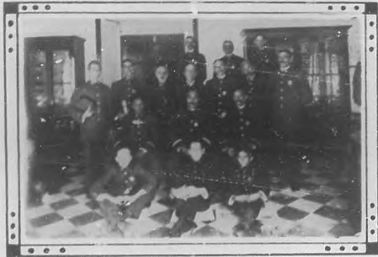
EL AYUNTAMIENTO DE LA HABANA.—Ordenanzas de la Administración Municipal.
