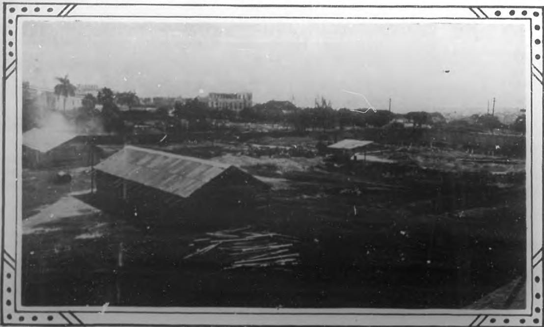
EL AYUNTAMIENTO DE LA HABANA.—Vista general de los terrenos que en la manzana 17 del Reparto "Jibacoa" enfrente a Carlos III, se construye el gran Hospital Municipal.
